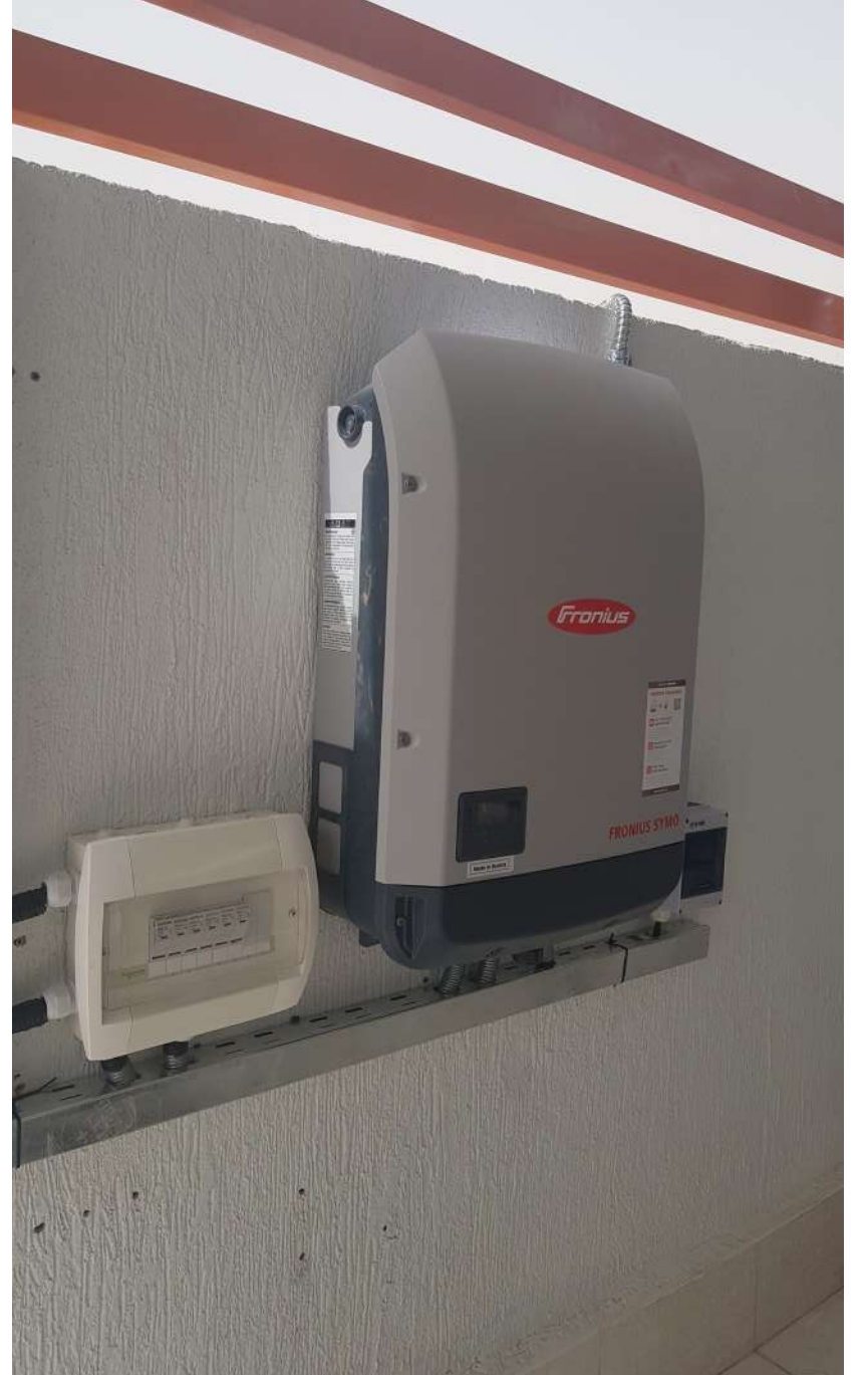
تركيب نظام 11 كيلو مربوط بشبكة الكهرباء بمكة المكرمة ON GRID SYSTEM 11 KW IN MAKKAH TRAFFIC
