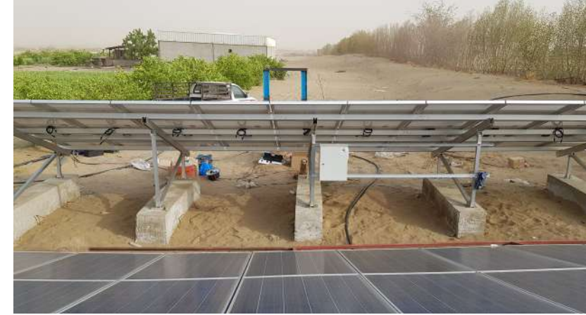
مشروع تركيب محطة لتشغيل مضختين بقوة 5.5 حصان وقوة 3 حصان بالقنفذة SOLAR WATER PUMP SYSTEM FOR PUMPS 5.5 AND 3HP IN AL-QUNFUDHAH CITY
