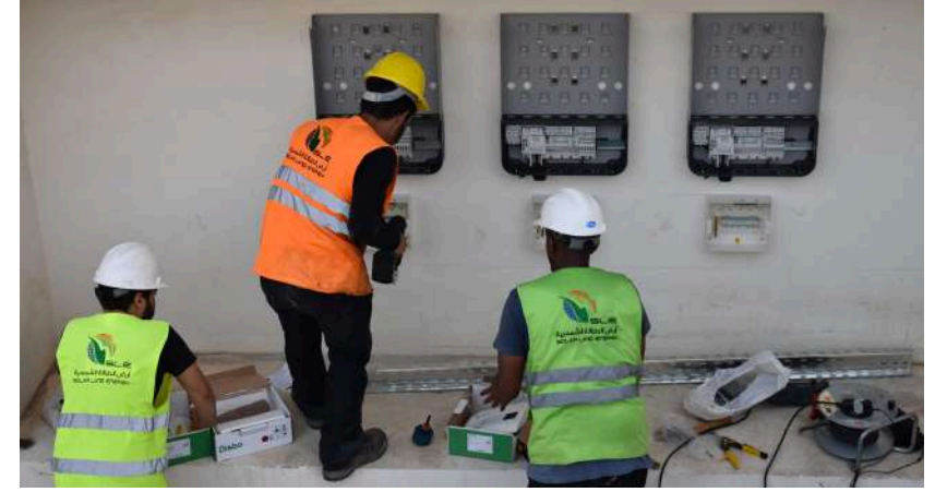
مشروع تركيب محطة مربوطة على شبكة الكهربائية بقدرة 54 كيلو وات بمركز الدفاع المدني بمحافظة جدة ON GRID SYSTEM 54 KW FOR CIVIL DEFENCE CEBNTER IN JEDDAH CITY
