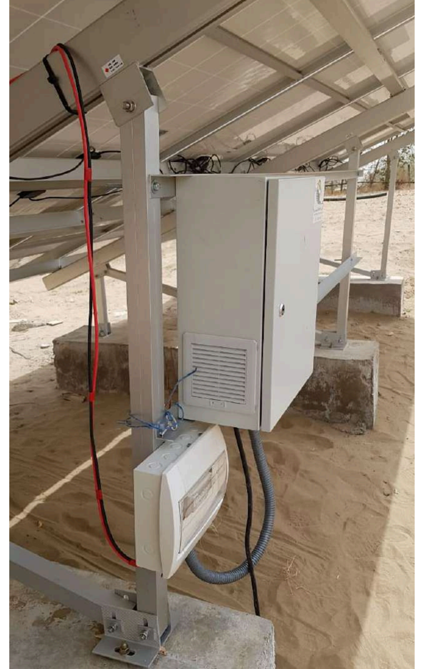
مشروع تركيب محطة لتشغيل مضختين بقوة 5.5 حصان وقوة 3 حصان بالقنفذة SOLAR WATER PUMP SYSTEM FOR PUMPS 5.5 AND 3HP IN AL-QUNFUDHAH CITY
