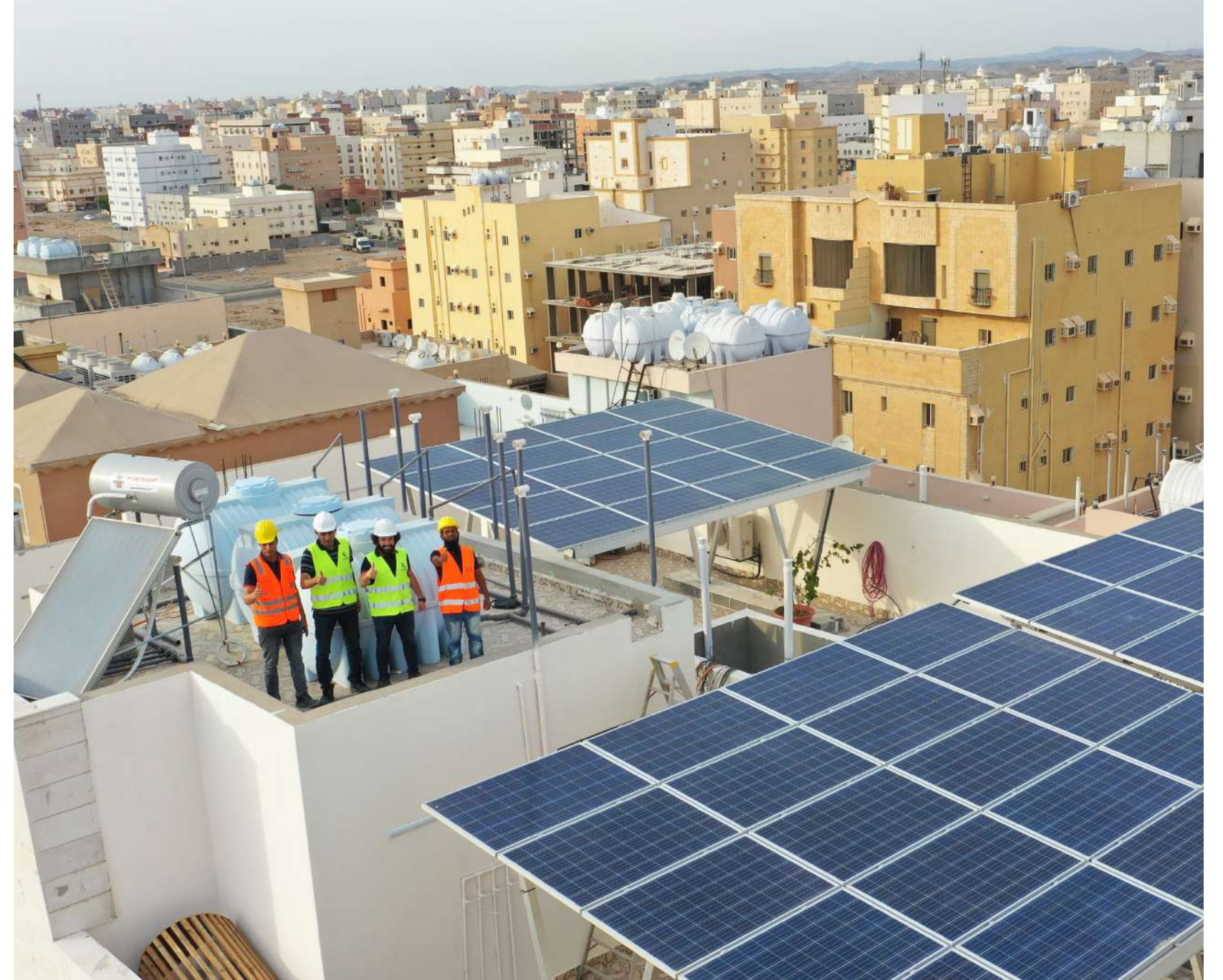
تركيب نظام ١٦.٢ كيلو مربوط على الشبكة بمدينة جدة ON GRID SYSTEM 16.2 KW IN JEDDAH CITY
